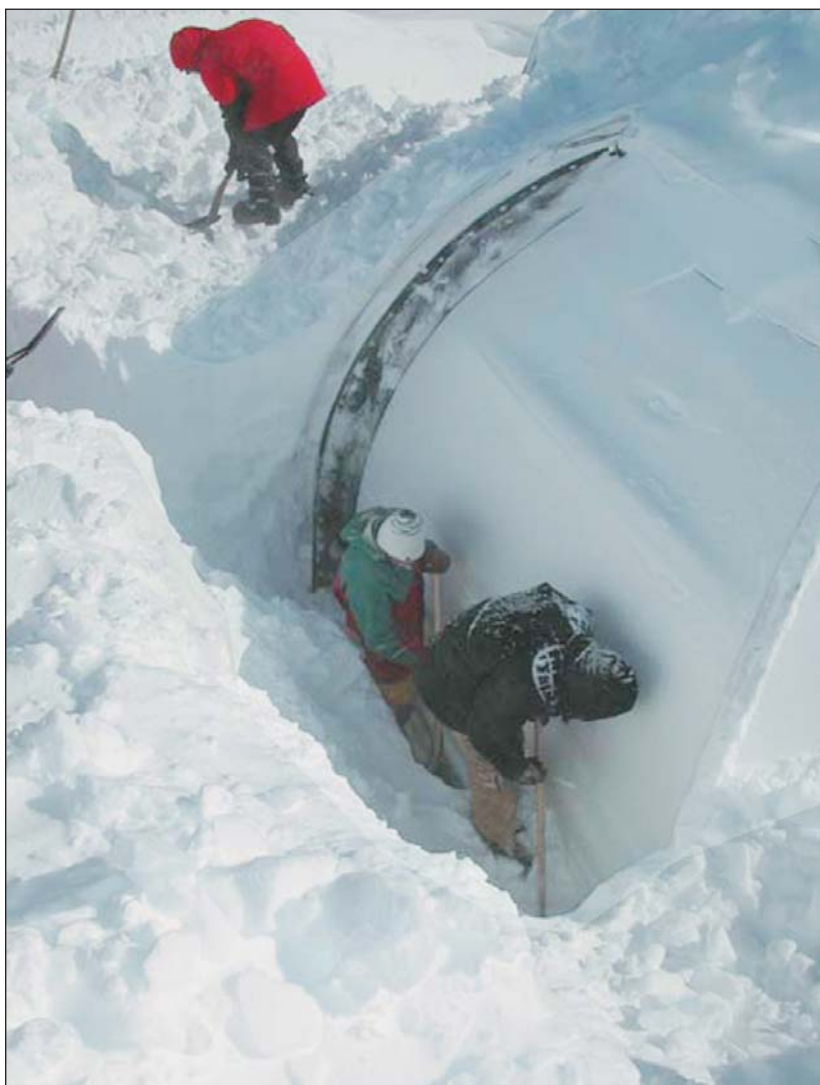
Вход в склад «Костел Люхта» пришлось откапывать лопатами.
